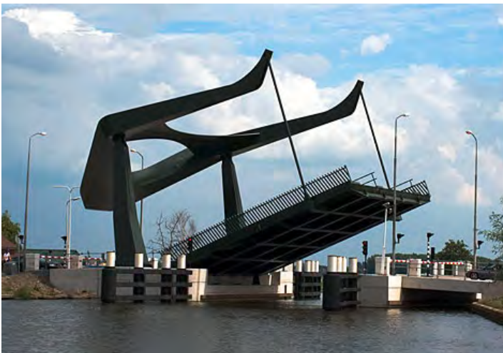
ZUGBRÜCKE „PRAYER OF SHADOW“: Die spektakuläre Brücke über die Amstel ist in RAL 6007 Flaschengrün lackiert. Innerhalb einer Minute lässt sich die High-Tech-Brücke in Vrouwenakker heben oder senken.
